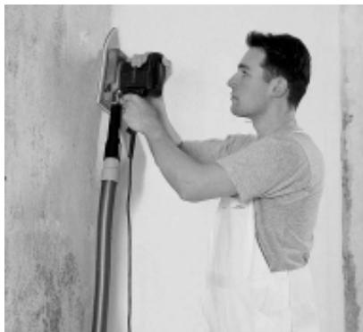
Aspiration des poussières contrôlée par la télécommande lors d'un travail avec un appareil électrique. Démarrage automatique de l'aspirateur à la mise en marche de l'appareil électrique. (N° de réf.: 58 405 1)
